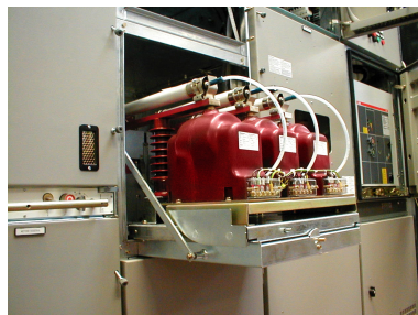
TV in posizione di estratto. VT draw-out position.
